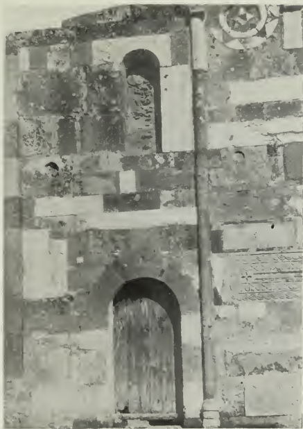
Chiesa di S. Platano in Villaspeciosa.
